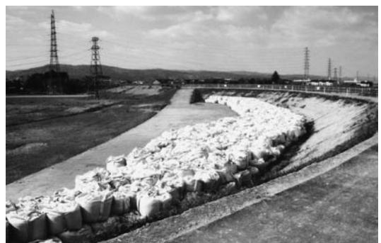
写真(8) 五十嵐川破堤地の仮締切 —三条市諏訪新田— 2004.8 (伊藤安男撮影)
